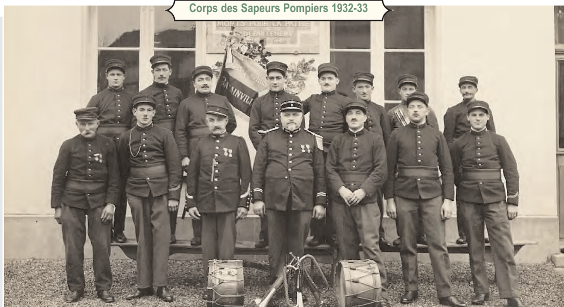
Corps des Sapeurs Pompiers 1932-33
