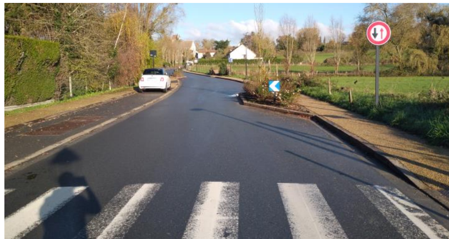
Figure 27 Apaisement à 30 et écluses à Bazainville, photo Vizea, novembre 2023
