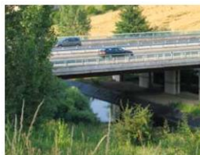
Ouvrage de franchissement de l'Opton
